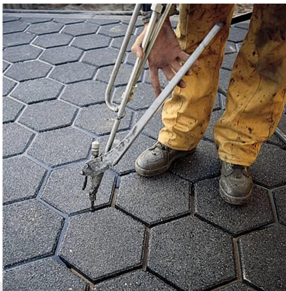
Foto: aanbrengen van voegvulmassa.
